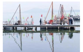
两湖隧道东湖试验段勘察
