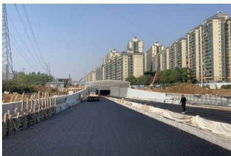
生态城大道施工现场
