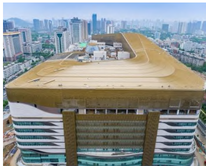
梦时代施工现场
